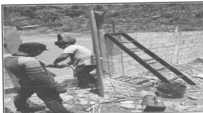
Foto 4: Se observa la instalación del portón de la entrada de la escuela.
