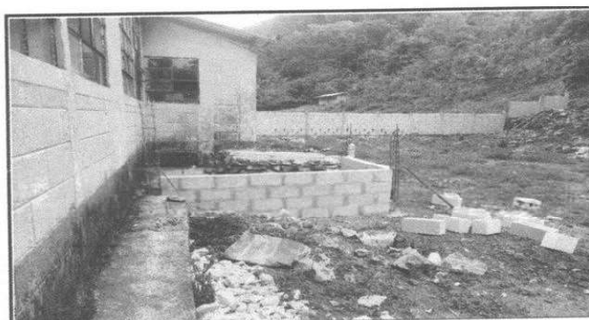
Foto 6: Se observa la construcción de la base del tinaco para el almacenamiento del vital líquido.
