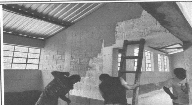
Foto 1: Se observa la remodelación del interior de la escuela.
